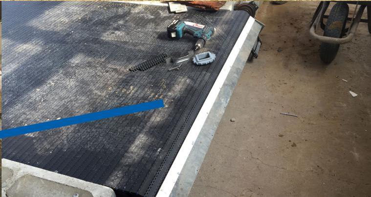
Untersuchung der neuartigen Emissionsminderungsmaßnahme „Schweinetoilette“ im Projekt KfreePig: Auf dem Kotplatz ist ein poröses, umlaufendes Band (Bild rechts) integriert. Es sorgt für eine frühzeitige Kot-Harn-Trennung und gewährleistet, dass die Tiere getrennte Kot- und Liegebereiche nutzen (Fotos: Ralf Remmert).
