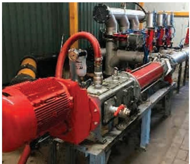
**Abb. 27: Substratverteilerpumpe**
