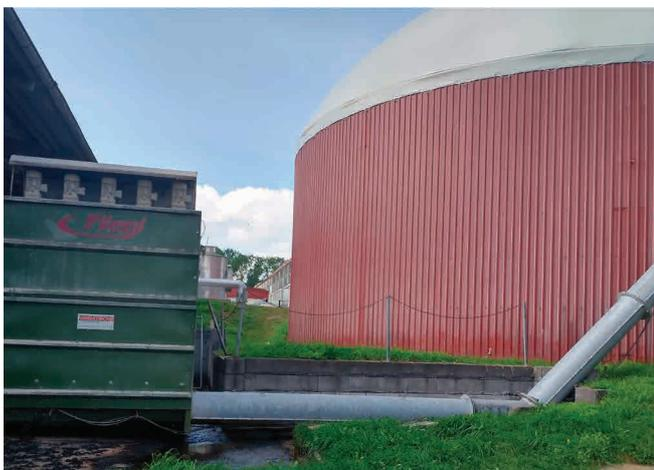
Abb. 19: Feststoffeintrag einer LaRA-Biogasanlage
