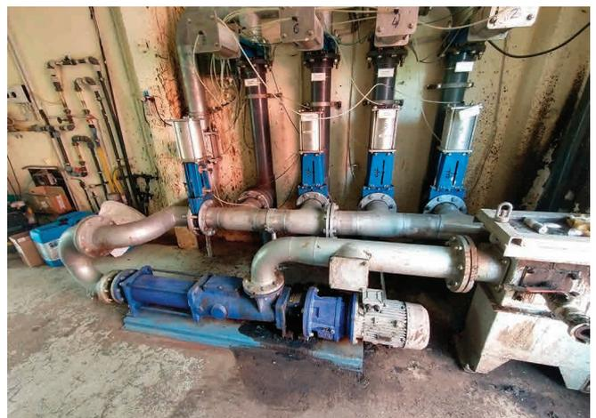
Abb. 20: Substratverteilerpumpe einer LaRA-Biogasanlage
